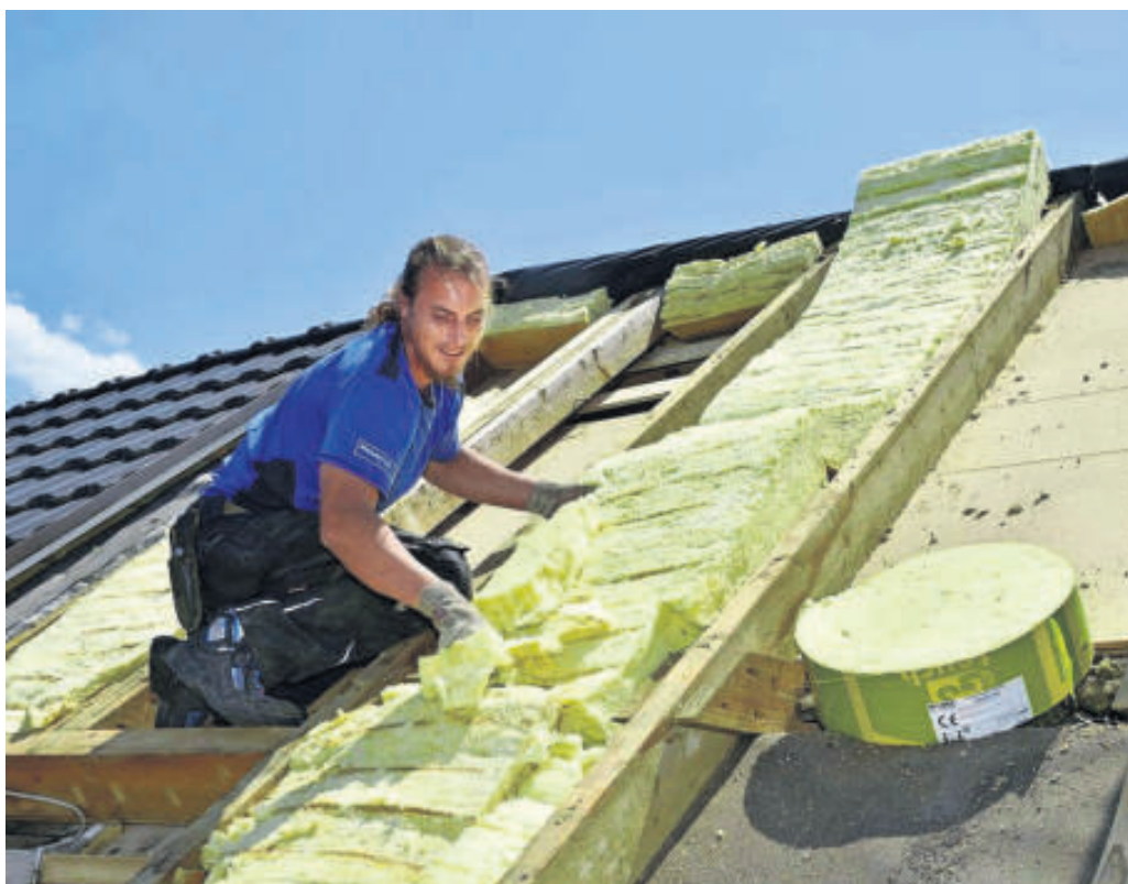
Handwerker setzen die Energiewende um. Zum Beispiel für die energetische Sanierung von Bestandsgebäuden werden in den nächsten Jahrzehnten viele Handwerker in den unterschiedlichsten Berufen gebraucht. Foto: hwk
